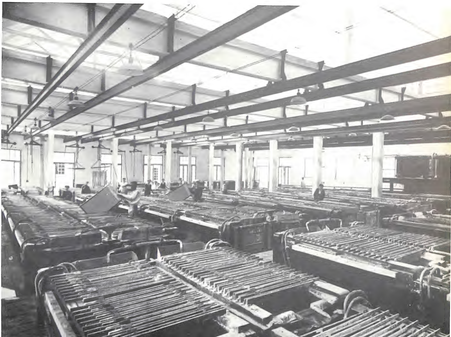
Monteponi - Sala delle celle per lo zinco elettrolitico.
